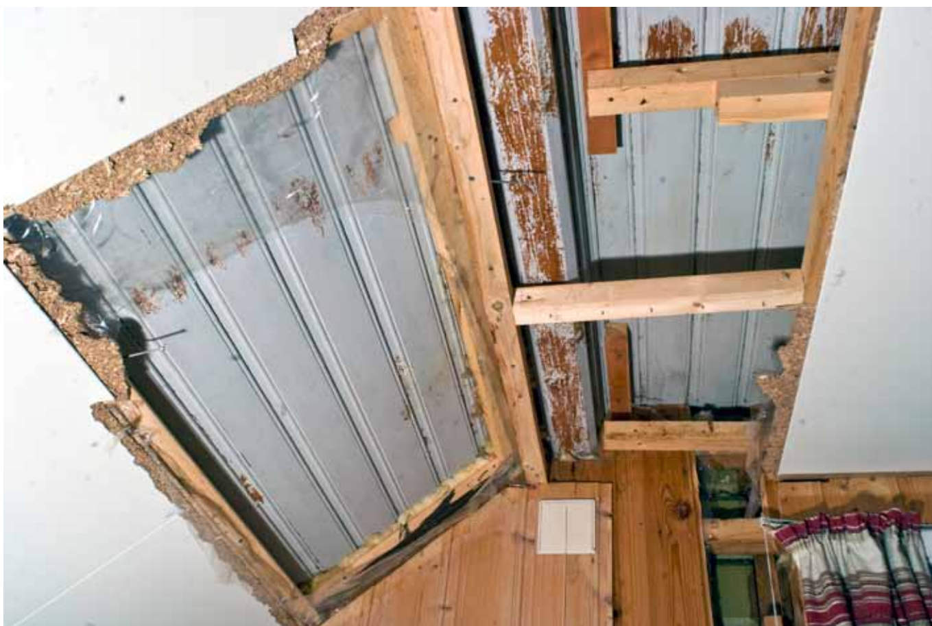
Under: Skråtak, himlingspanel og dekorativ bjelke i rom mot øst.
