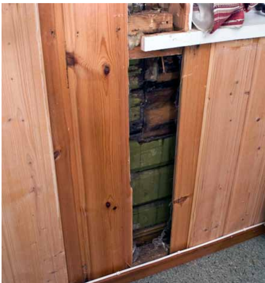
Under til høyre: Avdekket lafteplank, rom mot øst, ved nordøstre hjørne.
