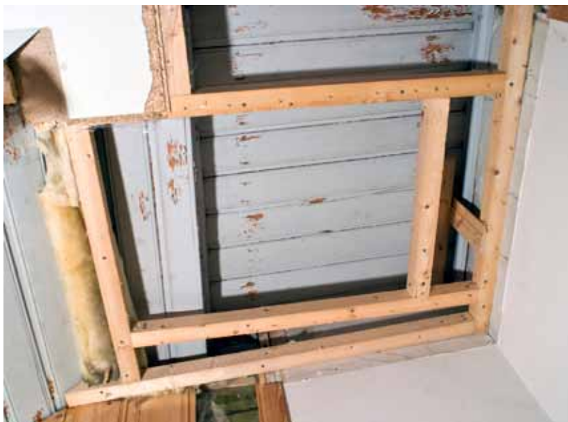
Over til venstre: Avdekket himling ved brannmur i rom mot øst
