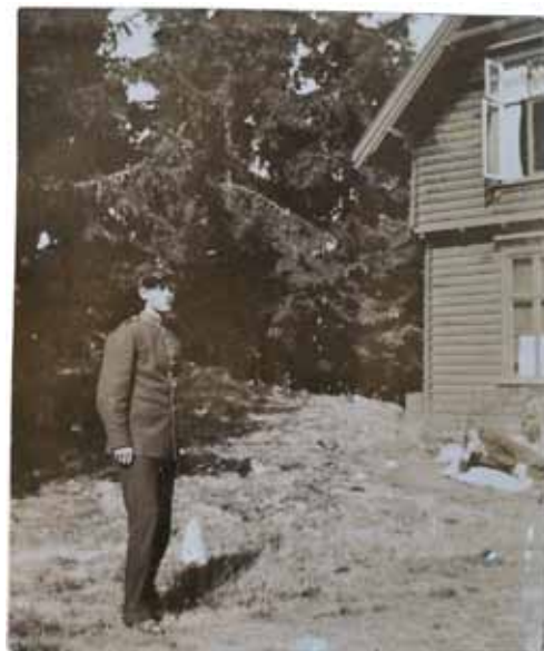
Bilde fra sommerhusperioden som viser østfasaden med opprinnelige vinduer. Fotografiet tilhører Johan Dahl.
