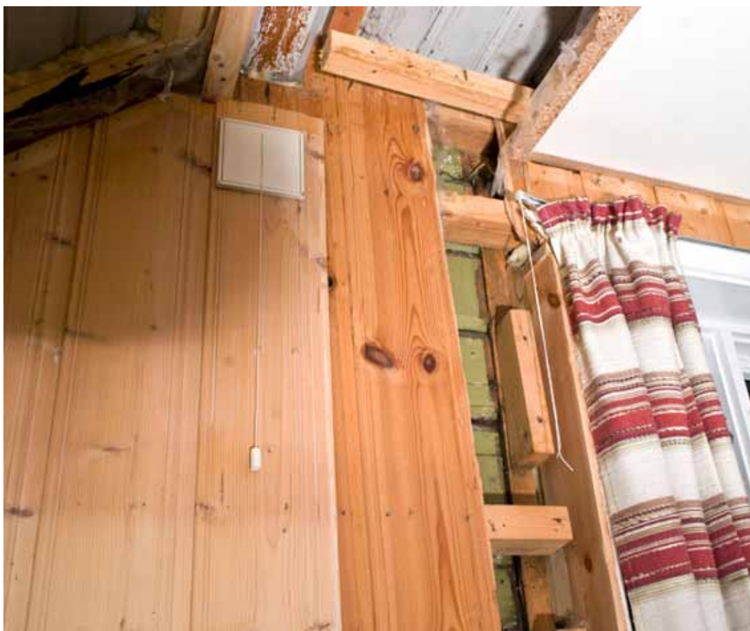
Over: Øvre del av vindusåpningen i tømmeret, vindu mot øst, avdekket.
